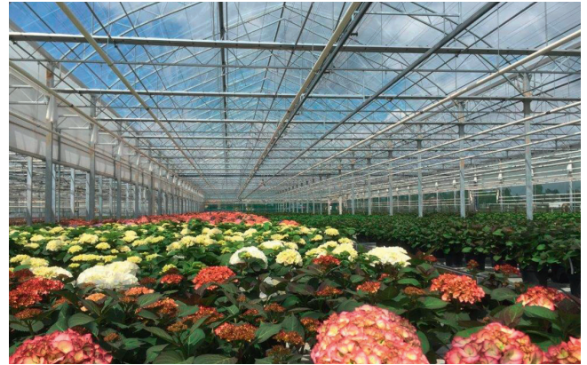
Bild 3. Gewächshausfolien aus ETFE sind langlebig und können das Pflanzenwachstum fördern. Das Gewächshaus im Bild wurde mit einer einschichtigen F-Clean-Folie überspannt © AGC Chemicals
